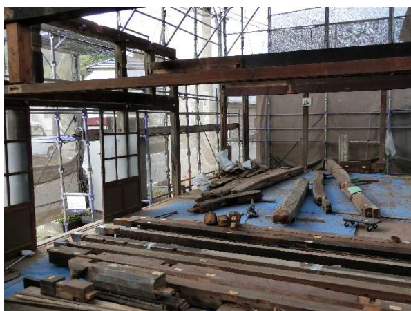
図1 解体・移築準備工事の様子
